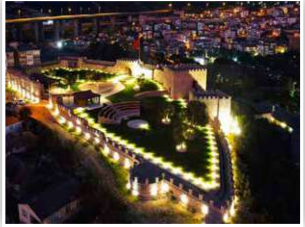
Körfez Belediyesi Hereke Kalesi Aydınlatma Yapım İşi
