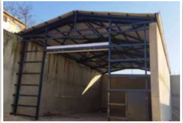
Kirazlıyalı depo çelik çatı ve çelik cephe inşaatı yapım işi
