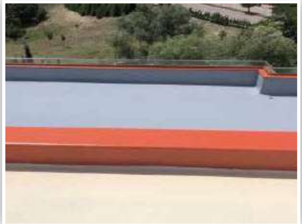
Körfez Belediyesine Ait Muhtelif Binalarda Su Yalıtımı ve Boya İşi
