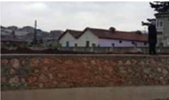
MUHTELİF YERLERDE TAŞ DUVAR YAPIMLARI
