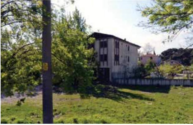
Güney Mahallesi, Körfez İlçe Müftülüğüne Tahsisi Yapılan Körfez Belediyesine ait 3Katlı Bina.
