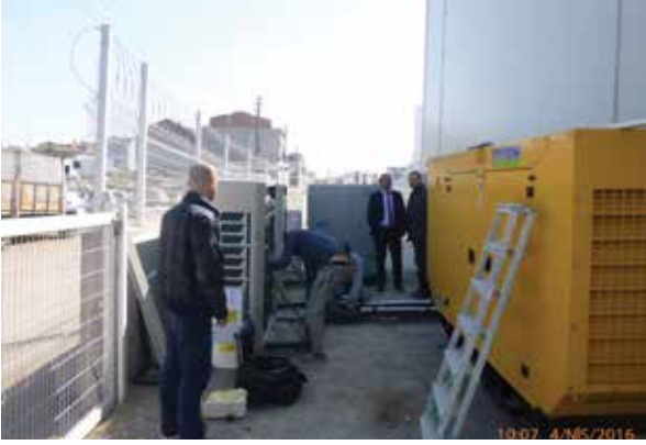
İŞ YERLERİNİN YAPIM AŞAMASINDA KONTROLÜ
