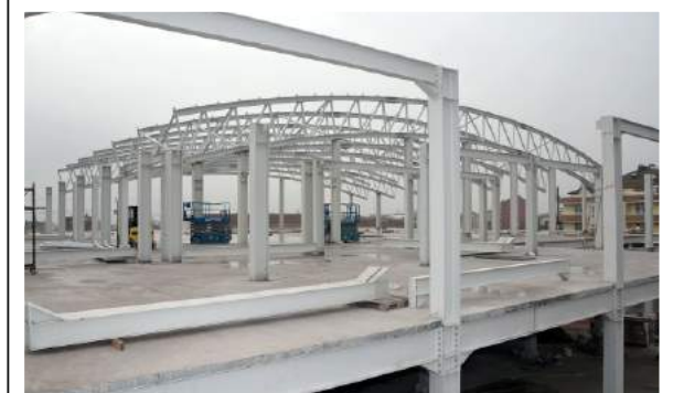
Yeniyalı Kapalı Pazar İnşaatı
