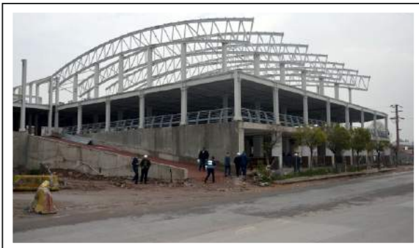
Yeniyalı Kapalı Pazar İnşaatı
